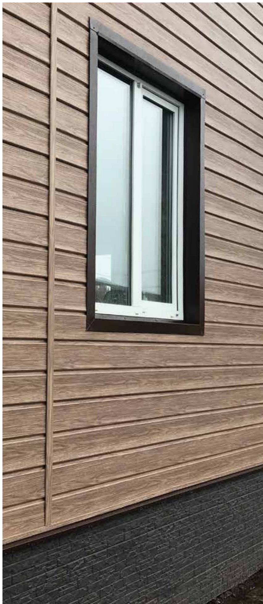
Пример монтажа сайдинга серии LUX под дерево
