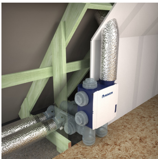
Аккуратный монтаж воздухопроводов в пространстве треугольной формы
