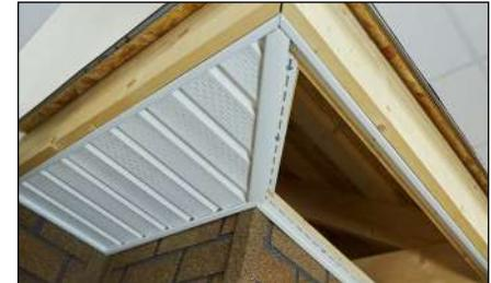
**3.4.** Установка H-профиля, предназначенного для соединения панелей в угловых зонах. Панели в данном случае подрезаем с учетом этого угла «елочкой». Фиксируем саморезами к обрешетке и стыкуем.
