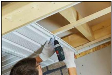
**1.4.** В направляющие профиля вставляются в панели и фиксируются при помощи саморезов к обрешетке.
