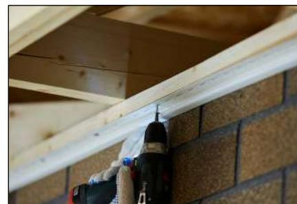
**1.3.** К обрешетке фиксируются направляющие профили (J-профиль) саморезами с шагом 300 мм. В месте соединения профилей подрезать часть профиля на 3-5 см и завести один профиль в другой для лучшего сопряжения.
