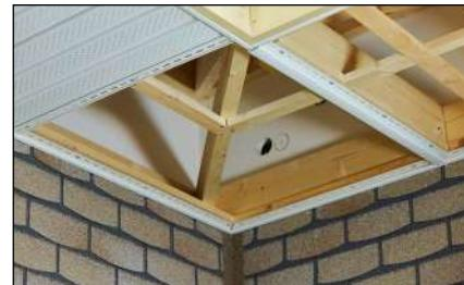
**3.5.** Прямое соединение выполняется с помощью H-профиля. Его монтируем от внутреннего угла перпендикулярно карнизу.
