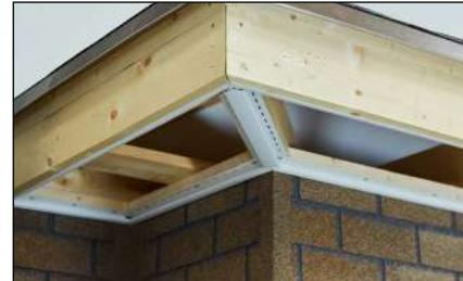
**3.3.** Для углового соединения панелей используется H-профиль.
