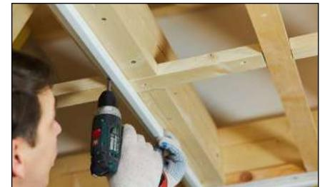
**3.6.** Второй вариант прямого соединения – при помощи J-профиля. Его устанавливаем от угла перпендикулярно одному из карнизов. Фиксируем саморезами к обрешетке и стыкуем друг с другом.
