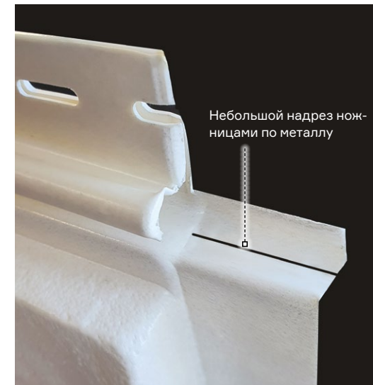
Рис. 16 Усиление жёсткости вертикального соединения панелей (необходимо выполнять при отдалении стойки обрешётки на расстоянии более 100 мм)
