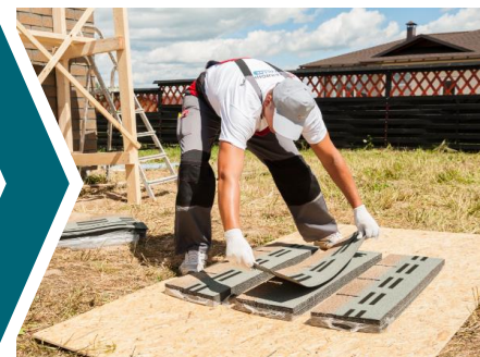
Перемешивание фасадной плитки
